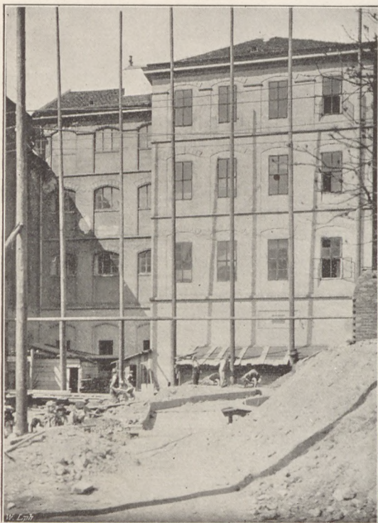
34. A gimnáziumi szárny városház-téri oldala.
