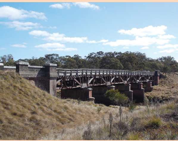
Régi, használaton kívüli vasúti híd Új-Dél-Wales (NSW) északi részén (Tenterfield)
