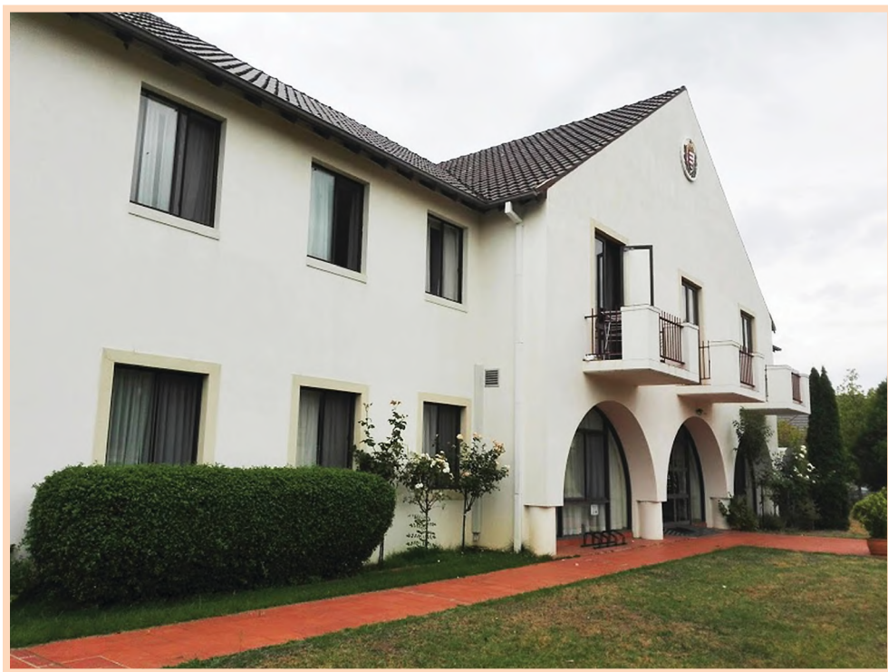
A magyar nagykövetség épülete oldalnézetből (17 Beale Crescent, Deakin ACT 2600) (Canberra)
