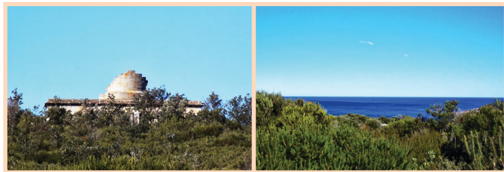
A Cape St George-i világítótorny romjai Jervis Bay-ben és a kilátás
