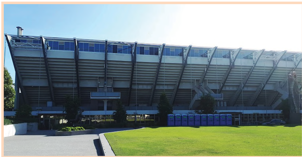
A vízilabdameccs egykori helyszíne (a korábbi Westpac, a jelenlegi Holden Centre) a melbourne-i olimpiai parkban. Az épület egy 1952-es nemzetközi tervpályázatot követően 1954–1956 között olimpiai uszodának készült, jelenleg a Collingwood FC edzőkomplexuma működik itt.
