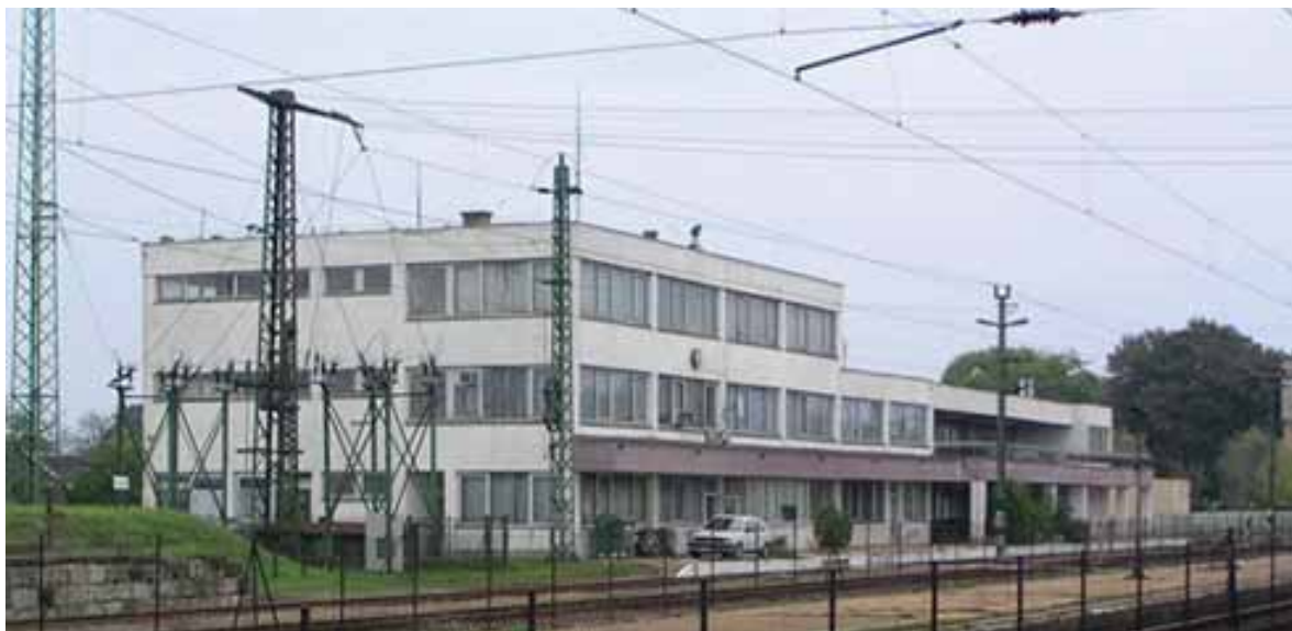
Bicske, vasútállomás, állomásépület
