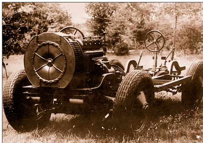
72. ábra: A WM Rt.-nél épített AC-I. 4x4-es páncélgépkocsi alváza (K. P.)
