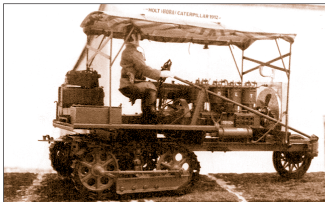
28. ábra: A Lipták-féle harckocsik közös alapjárműve a Holt-Caterpillar traktor modellje (H. A.)
