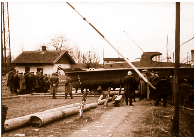
86-89. ábra: A Balatonfüredi hajógyárból 1941 márciusában az AM 1 és AM 2 aknász motorcsónakot vasúton a Tisza partjára szállították, és ott újra vízre bocsátották (B. J.)
