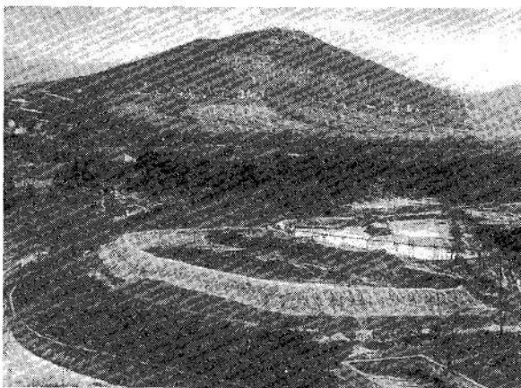
6.2.1-7. ábra. Az ércelőkészítő üzem meddőiszaphányó mint tömedéktermelő hely
