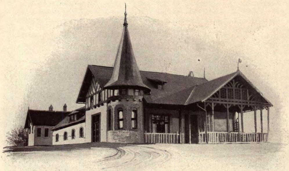
Bácsalmás. — Gróf Teleki Jánosné úrilaka.
