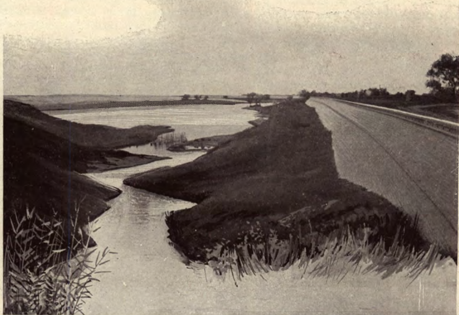
A Jegricska-bara és betonburkolatu töltése Zsablyánál.
