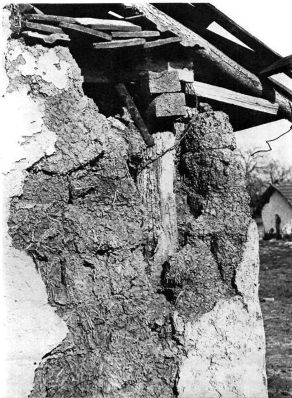
A cölöp- és tetőszervezet összekötése (Részlet a 72. sz. képből)
