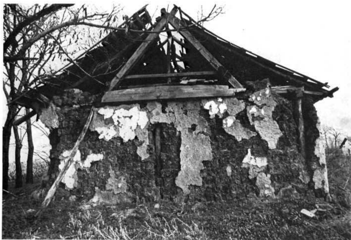
A széteső épületből előtűnik a „cölöpszerkezet” és a tetőszerkezet (IX. dűlő Tódor Nagy József tanyája)
